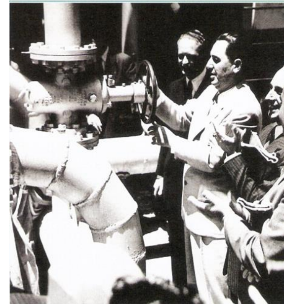
El Gran Gasoducto
